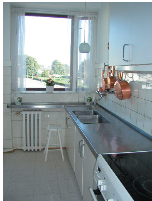
Vinkel stål bordpladen på en 2. sal, hvor den smalle side ligger udenfor vindueslysningen.
