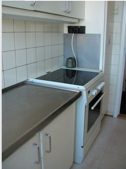
Stål stænkplade på højskabet ved komfurpladsen.
