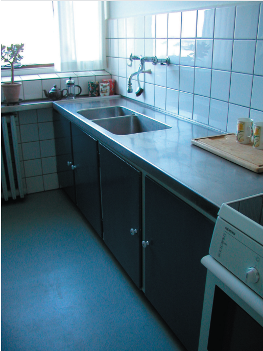
Vinkel stål bordpladen med den nedfældede vask og den oprindelige vandhane med forsyning fra badeværelset.
