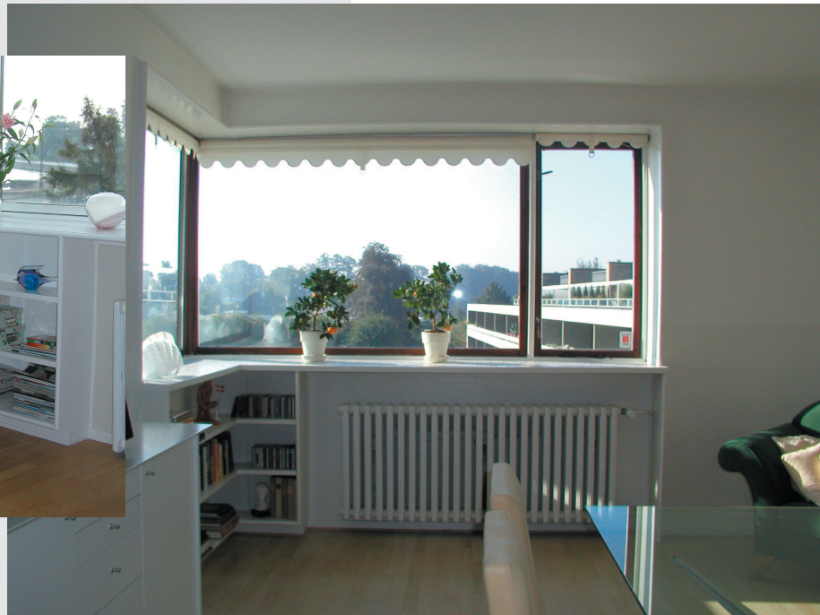
Hjørnevinduesparti i stue med reol og radiator under vinduespladen.
