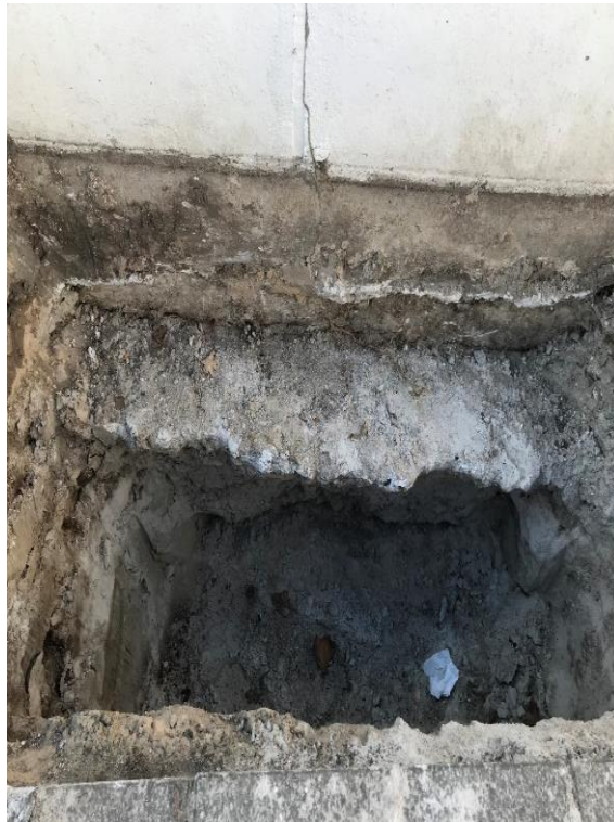
Udgravning fundament til frostfrit niveau. Der findes en vandret hylde under terræn, som medvirker til at støtte muren.
